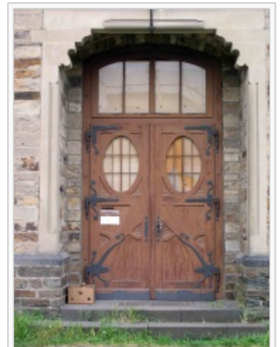
Der Haupteingang zum Gebäude der ehemaligen Präparandie.
