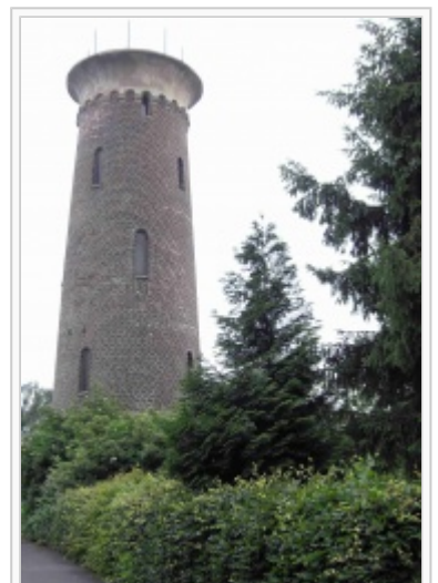
Der Wasserturm von Kripp - aus nördlicher Richtung fotografiert.
