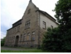
Die Ost-Fassade der ehemaligen Präparandie.
