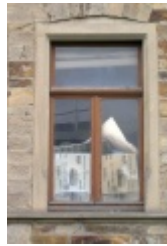
Eines der Fenster im Erdgeschoss der Präparandie-Fassade.
