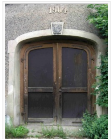
Die Eingangstür zum Kripper Wasserturm.
